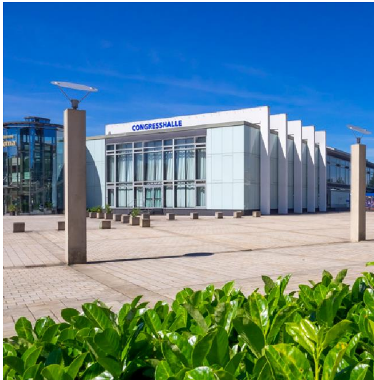
Abbildung 69: Congresshalle, Ansicht aus der Hafenstrasse
