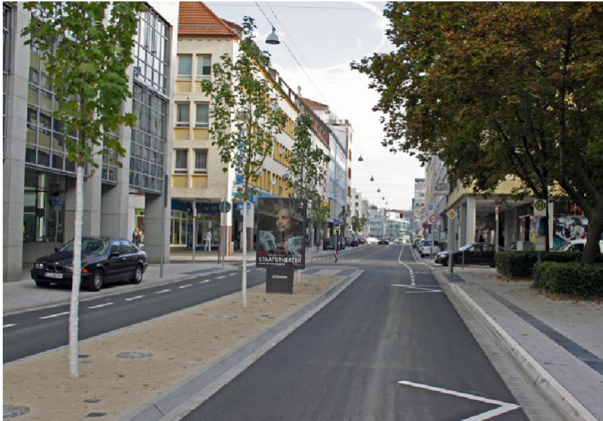
Abbildung 53: Eisenbahnstraße nach Umgestaltung
