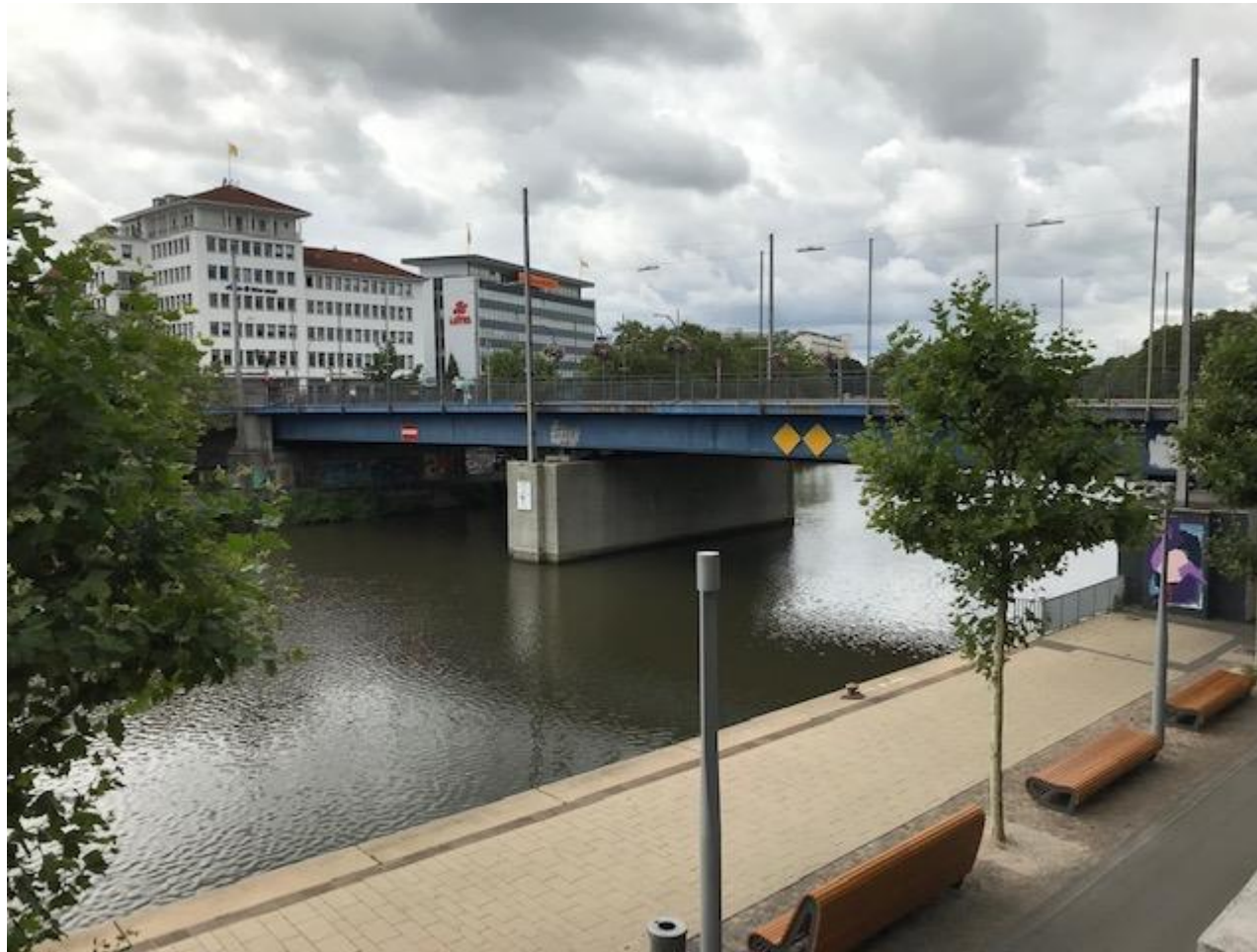
Abbildung 98: Luisenbrücke Bestand, Seitenansicht Baukonstruktion, Quelle: LHS
