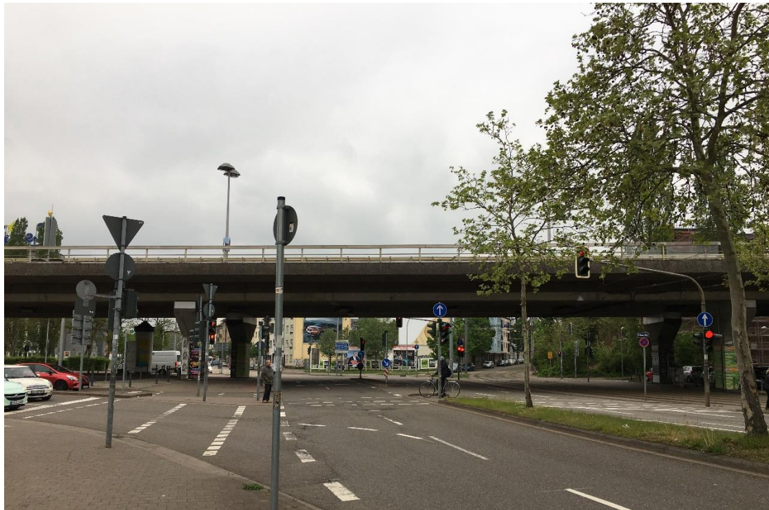
Abbildung 119: Bestandssituation Kreuzungsbereich unter der Westspange, Quelle: GIU
