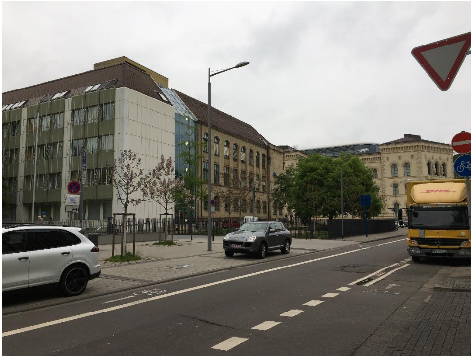
Abbildung 139: Bestandssituation Faktoreistraße, Quelle: GIU
