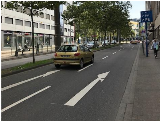
Abbildung 129: Bestandssituation St. Johanner Straße, LHS 2021
